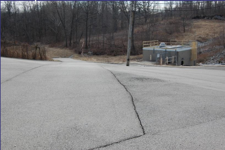
Fill asphalt cracks
