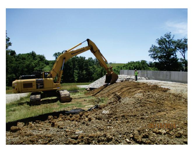
Photo 178: Backfilling over 8-inch forcemain. Jun. 2016
