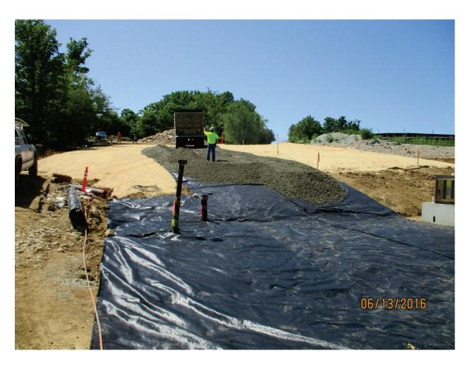
Photo 179: Placing #53 stone for WW4 access road. Jun. 2016
