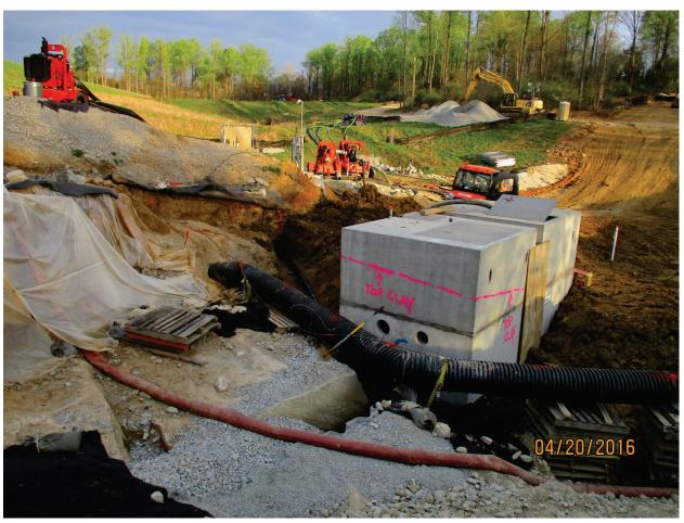
Photo 119: Clay level around WW chambers. Apr. 2016
