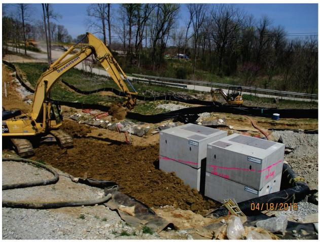
Photo 116: Backfilling around WW chambers. Apr. 2016
