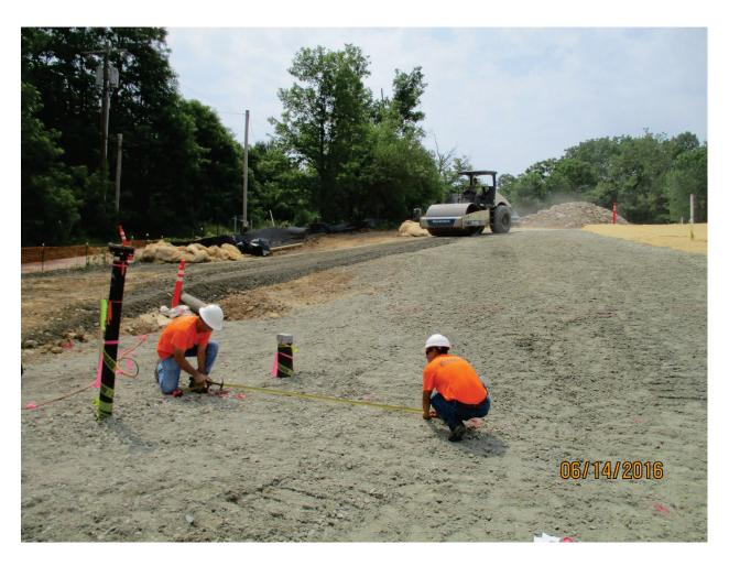
Photo 182: Laying out diesel pump pad. Jun. 2016
