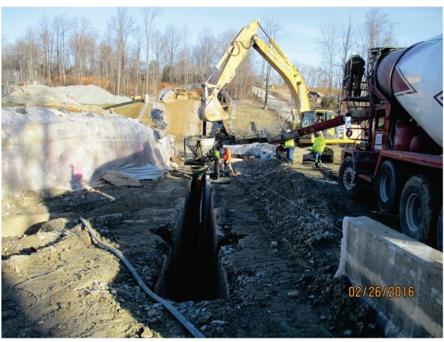
Photo 63: Pouring grout using concrete bucket. Feb. 2016
