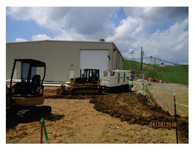
Photo 128: Removal of generator for GWTP. Apr. 2016
