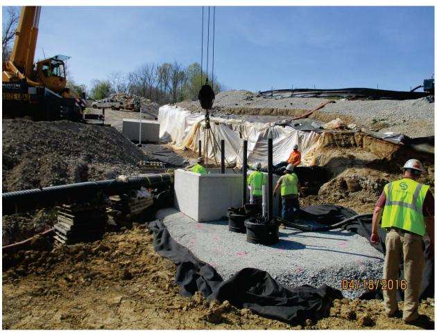
Photo 114: Setting south chamber base for WW sumps. Apr. 2016
