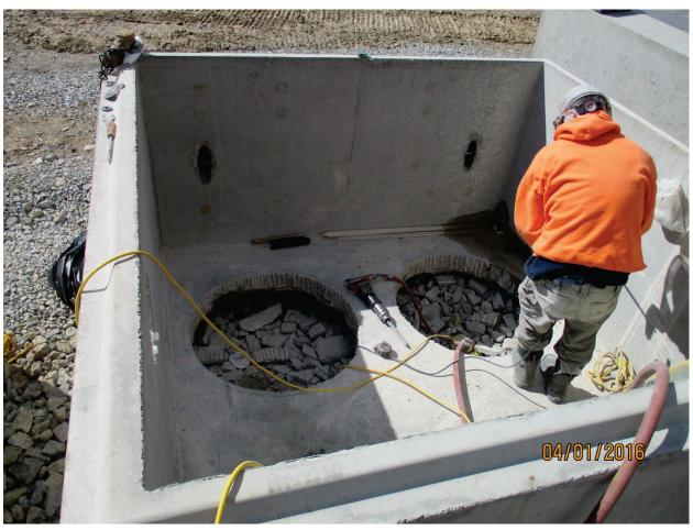
Photo 99: Cutting holes in WW chamber. Apr. 2016
