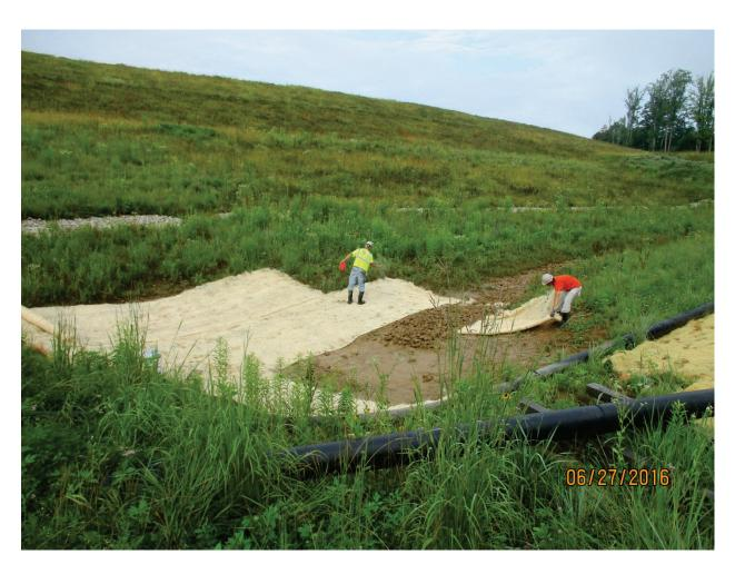
Photo 190: Seeding and placing erosion control mat in DB-3. Jun. 2016
