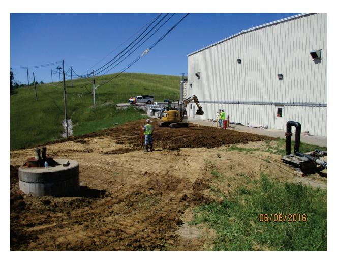
Photo 172: Grading topsoil over PIV and MHs. Jun. 2016
