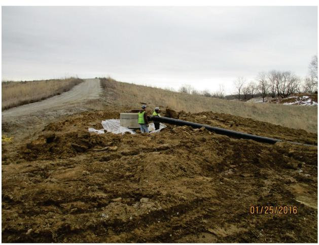
Photo 45: Setting pipe into MH-7. Jan. 2016
