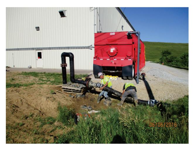
Photo 165: Backwash pipe connected for SW pond discharge. Jun. 2016
