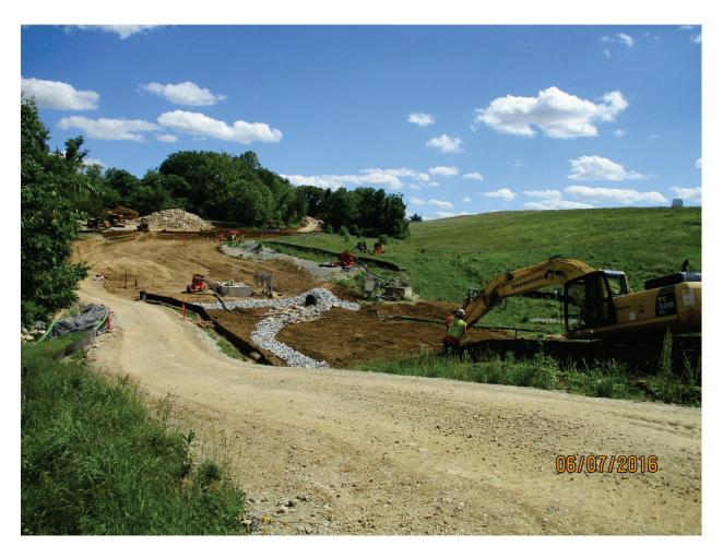
Photo 171: Grading topsoil over trench area. Jun. 2016
