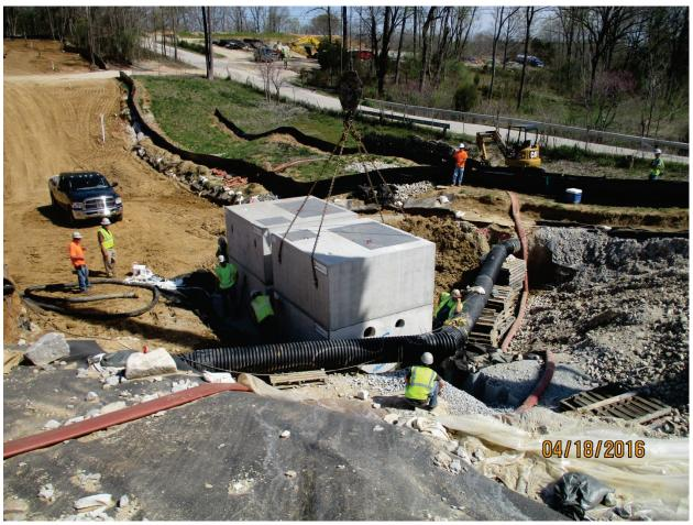
Photo 115: Setting top of south chamber for WW sumps. Apr. 2016
