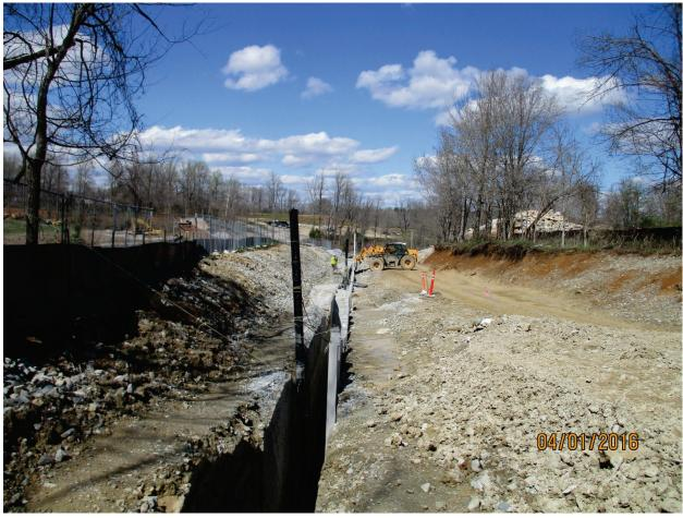
Photo 98: Stone backfill in south trench. Apr. 2016
