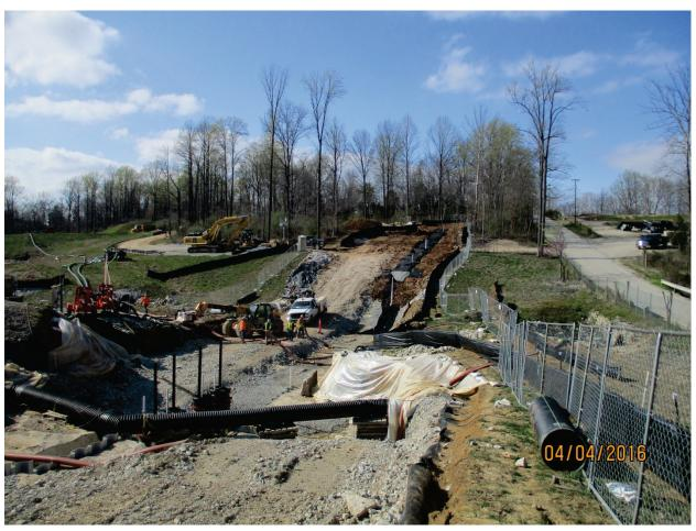
Photo 101: Covered filtration media over north trench. Apr. 2016
