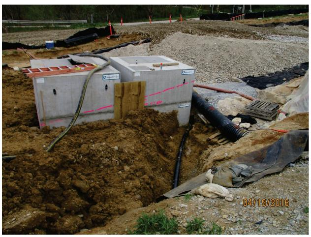
Photo 118: Overflow pipe from WW3. Apr. 2016
